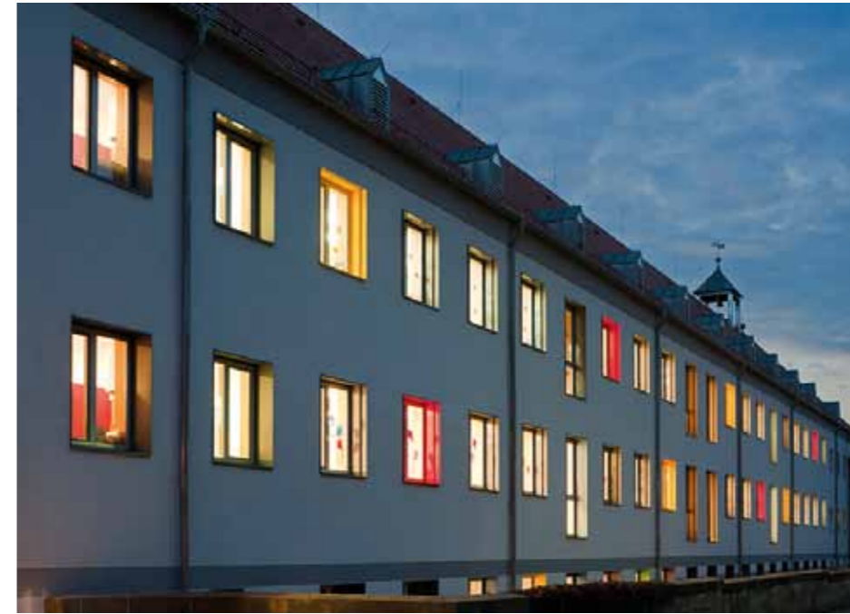
Farbig gestaltete Fensterleibungen zeichnen die Farben der Klassenzimmer nach außen ab
