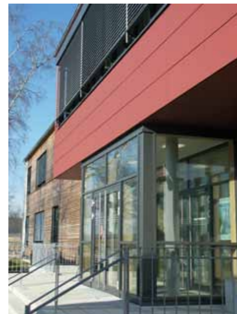
Die neue Eingangshalle als Verbindungselement zwischen den Schulen
