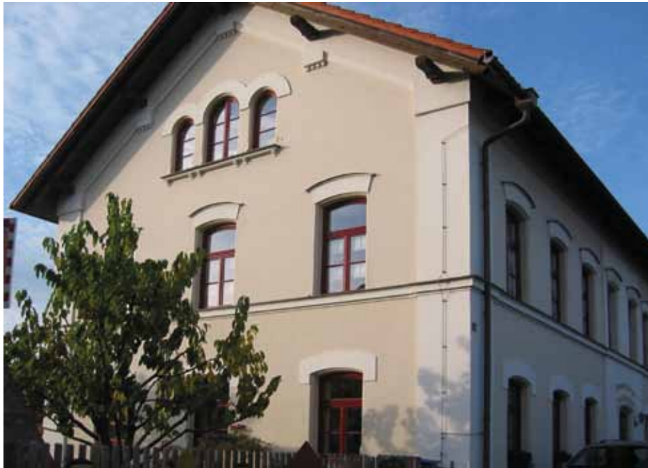
Sanierte Fassade des denkmalgeschützten Gebäudes
