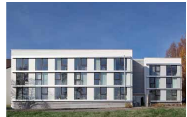
Neues Erscheinungsbild durch den Abbau der Balkone
