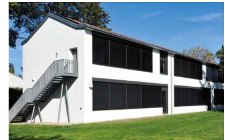
Blaubau nach der Maßnahme
