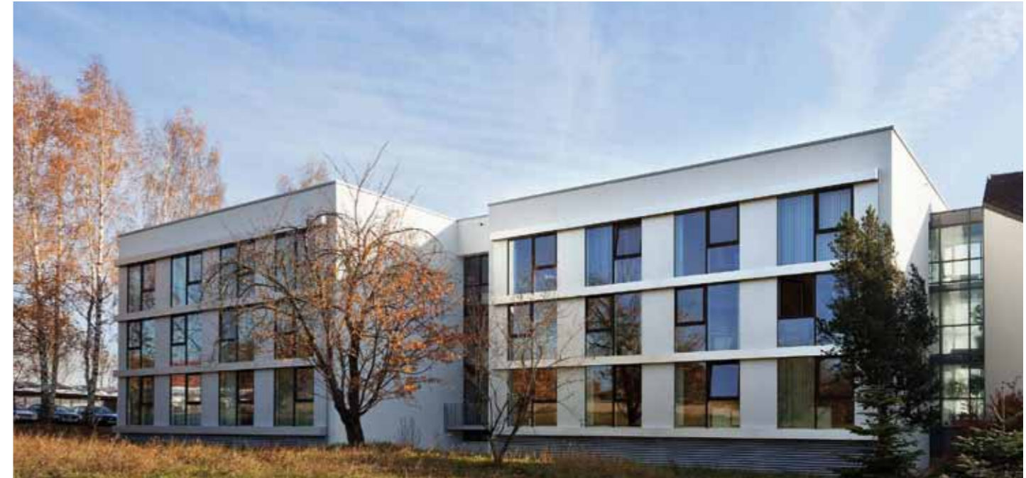
Neue Pfosten-Riegel-Fassade mit vorgesetztem Sonnenschutz
