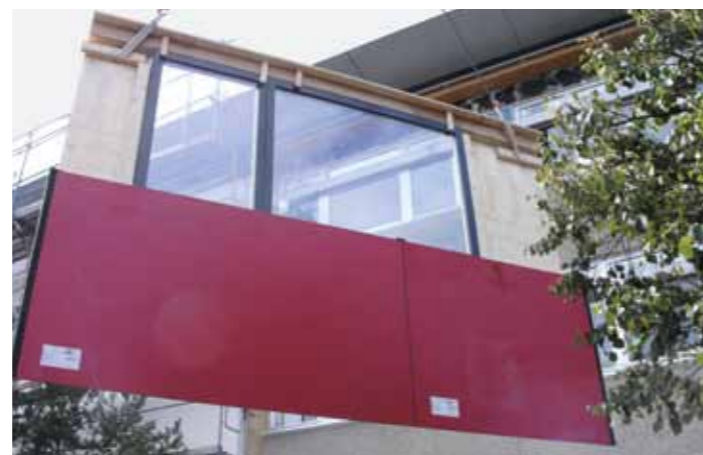
Fassadenelement beim Versetzen
