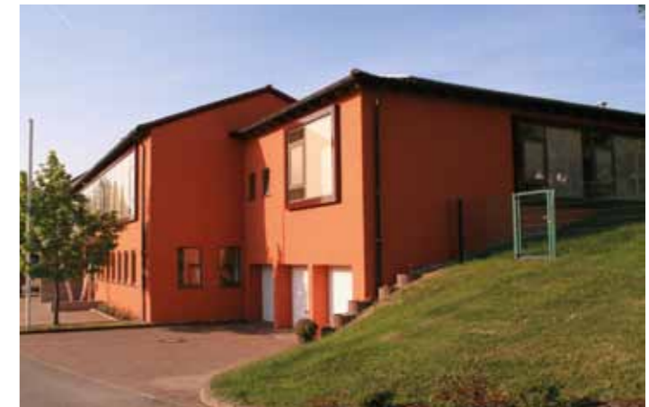
Zweigeschossige Eingangsfront nach dem Umbau
