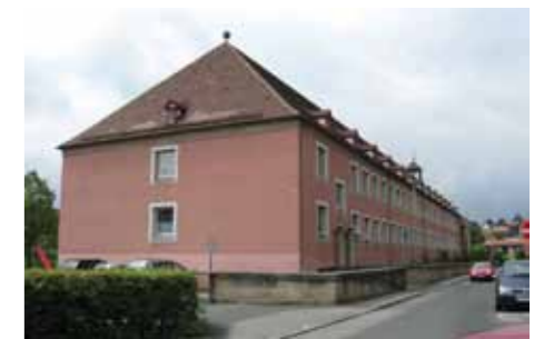
Fassadenansicht vor der Sanierung
