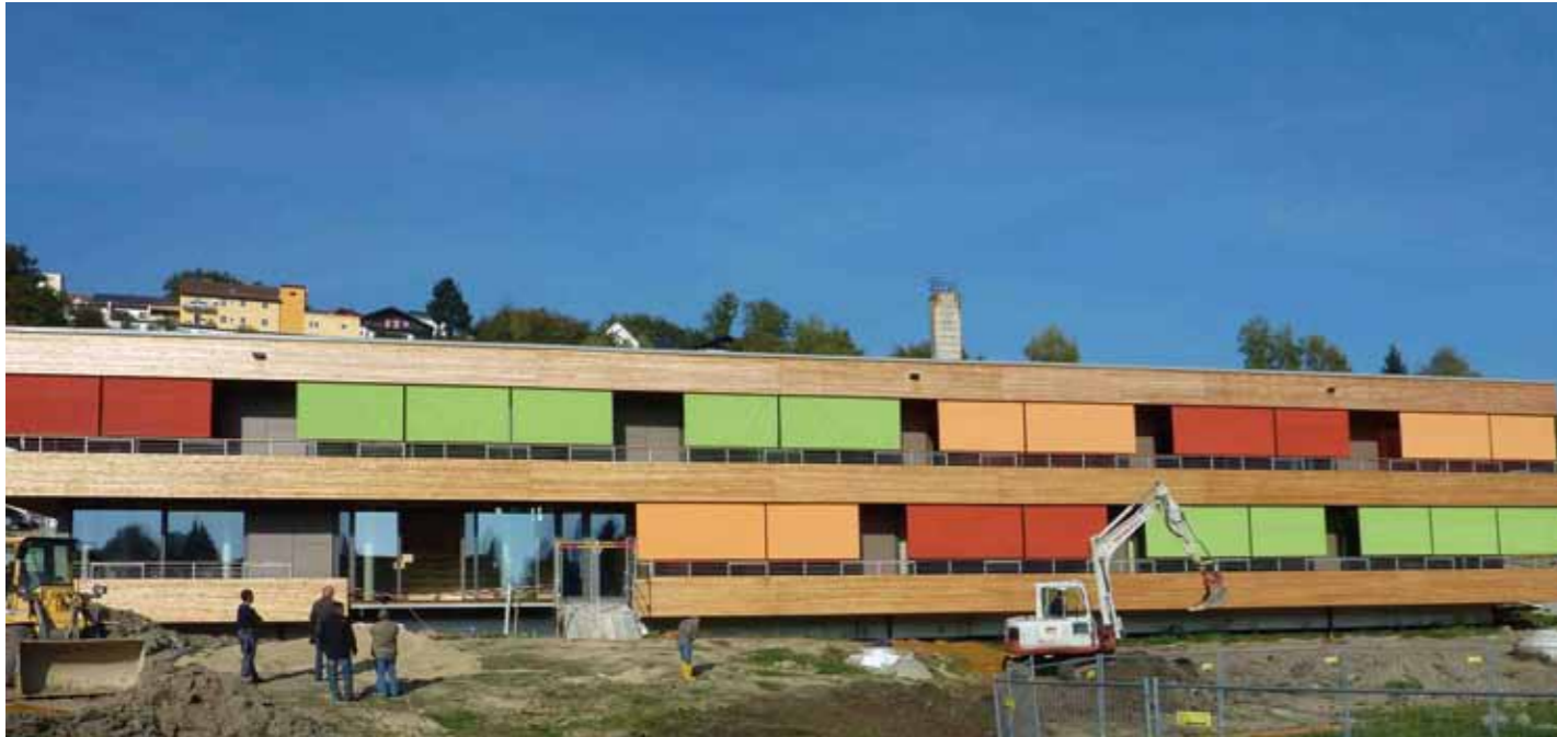
Durch die individuelle Bedienung des farbigen Sonnenschutzes wird der Südfassade immer wieder neuer Ausdruck verliehen
