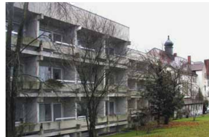
Gesundheitsamt vor der Sanierung
