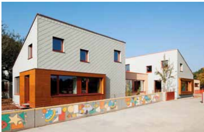
Die Gruppenräume sind jetzt als eigenständige Häuser ablesbar
