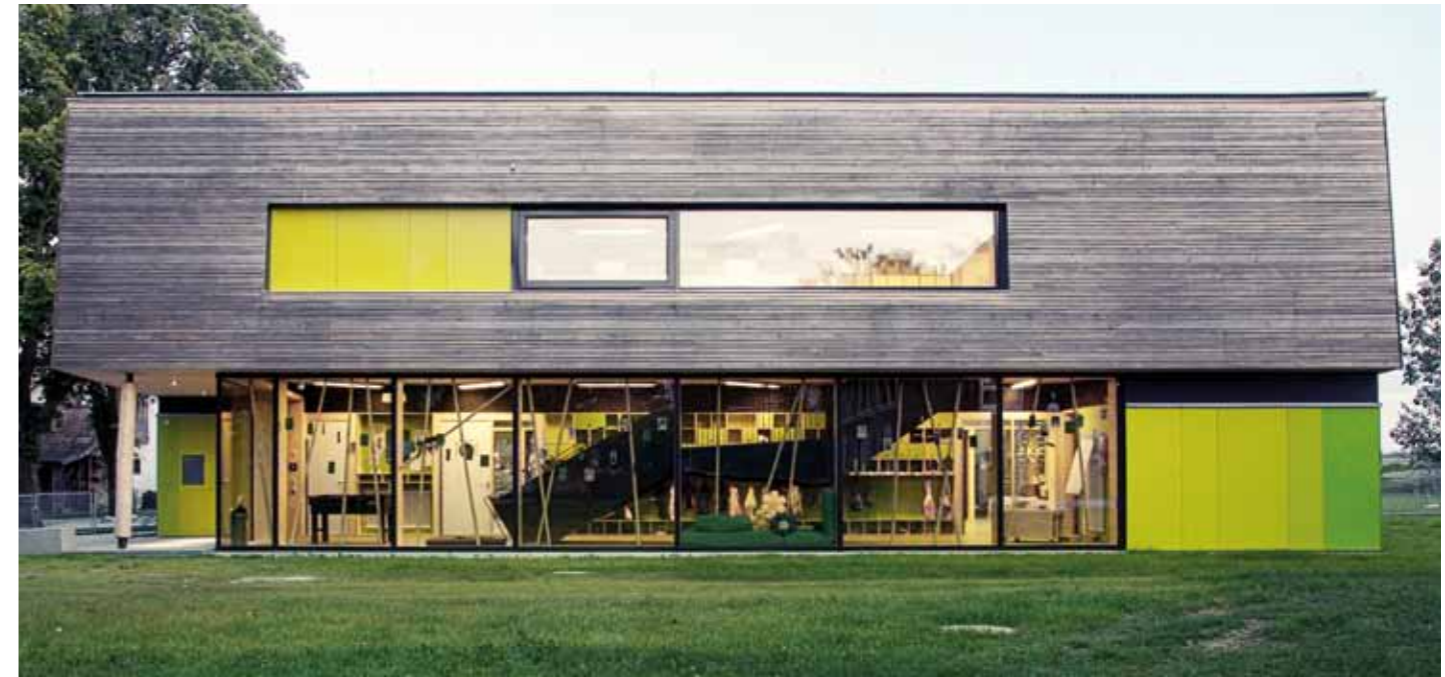
Nordfassade des Ersatzneubaus
