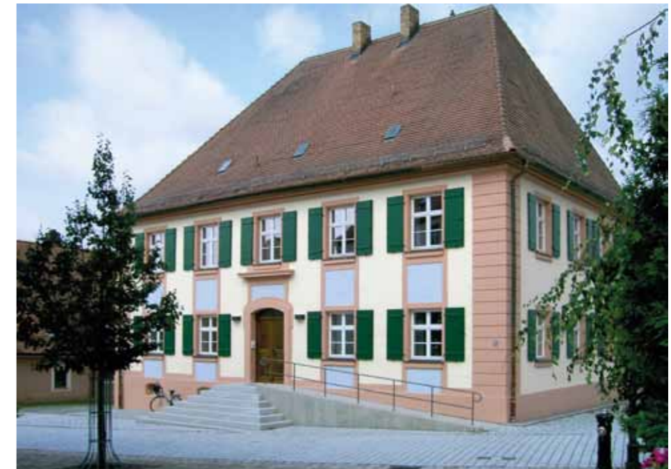
Vorderansicht des Steingruber-Hauses mit neuer behindertengerechter Zugangsrampe
