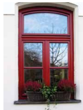
Rekonstruktion der Fenster nach alten Fotografien
