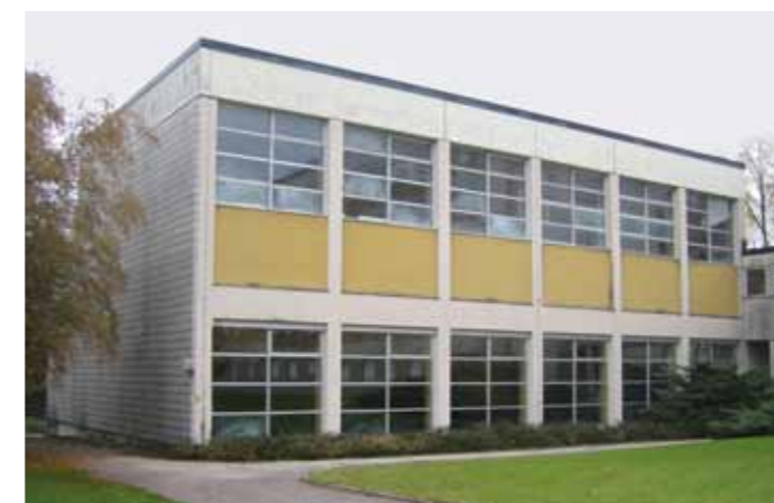
Gebäudeaufwertung durch vollständige Erneuerung der Fassade
