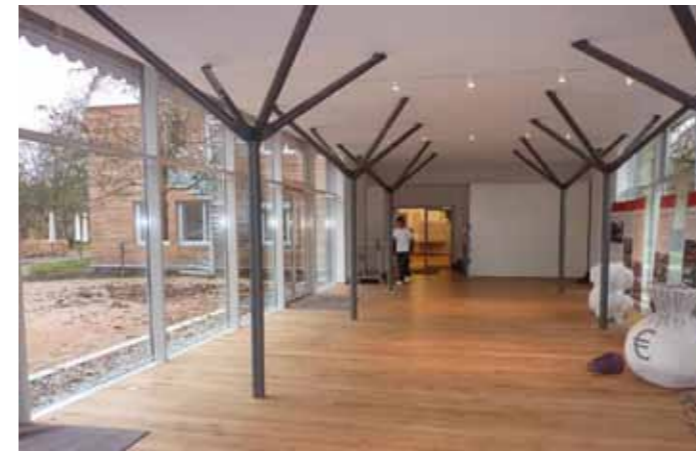
Baumartige Stützen im neuen Verbindungsgang
