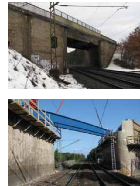
Bahnbrücke vor und während des Umbaus
