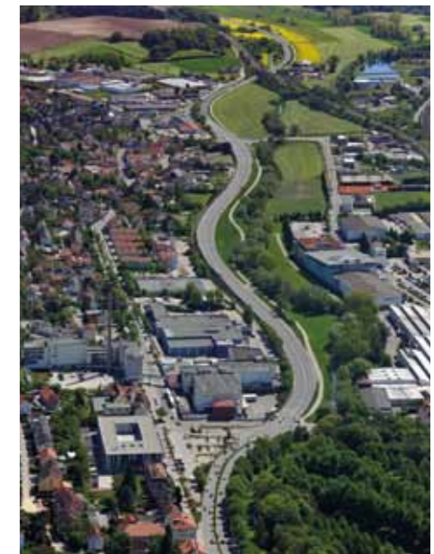
St 2223 in Ansbach nach der Fertigstellung
