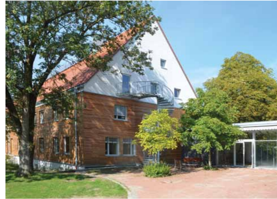
Saniertes Seminarhaus mit neuem Verbindungsgang
