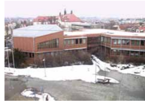
Landratsamt vor der Sanierung
