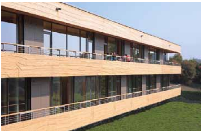
Horizontale Gliederung des Gebäudes durch den umlaufenden Fluchtbalkon
