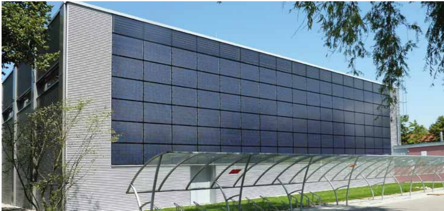
Südfassade der Sporthalle mit integrierten Flächen für Solarthermie und Photovoltaik
