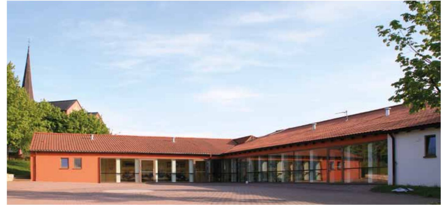
Pausenhof der sanierten Grundschule
