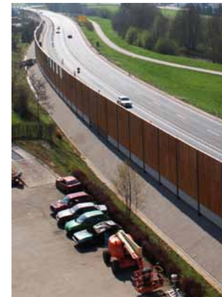
Lärmschutz entlang der St 2223
