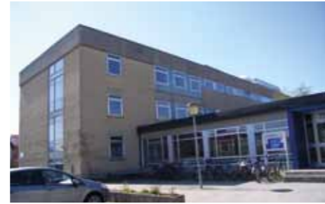
Klassentrakt mit Eingangsgebäude vor der Maßnahme
