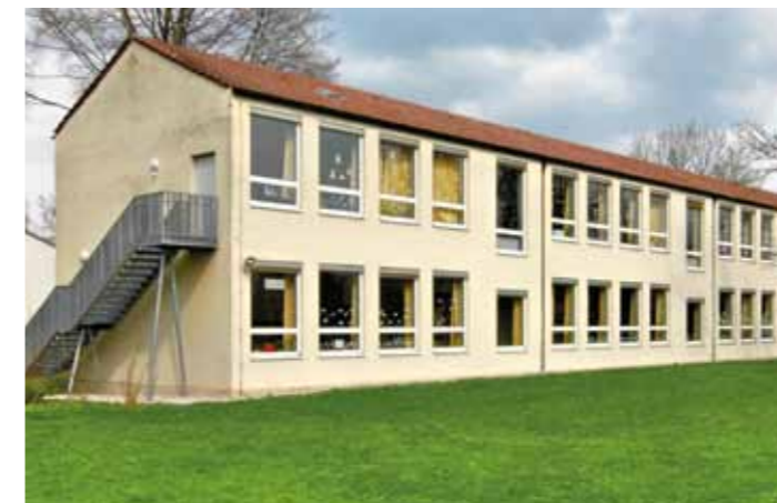
Blaubau vor der Maßnahme
