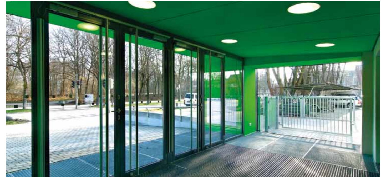
Neu errichteter Windfang
