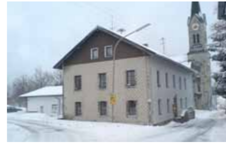
Rathaus vor der Sanierung
