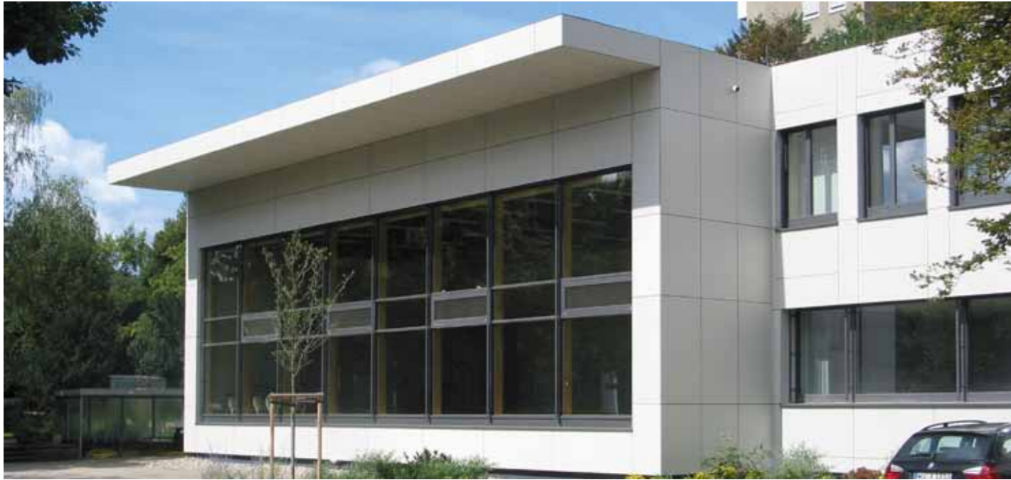
Neugestaltung der Sporthalle
