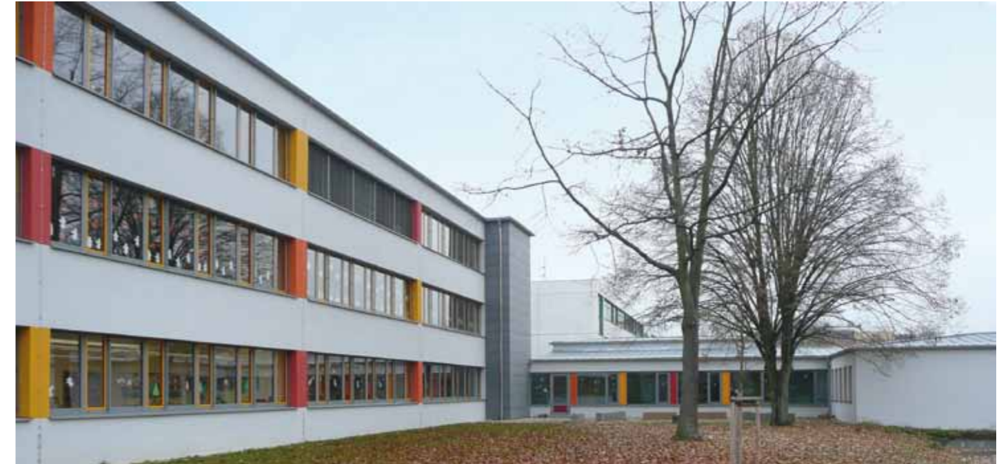
Gliederung des Gebäudes durch farbige Elemente
