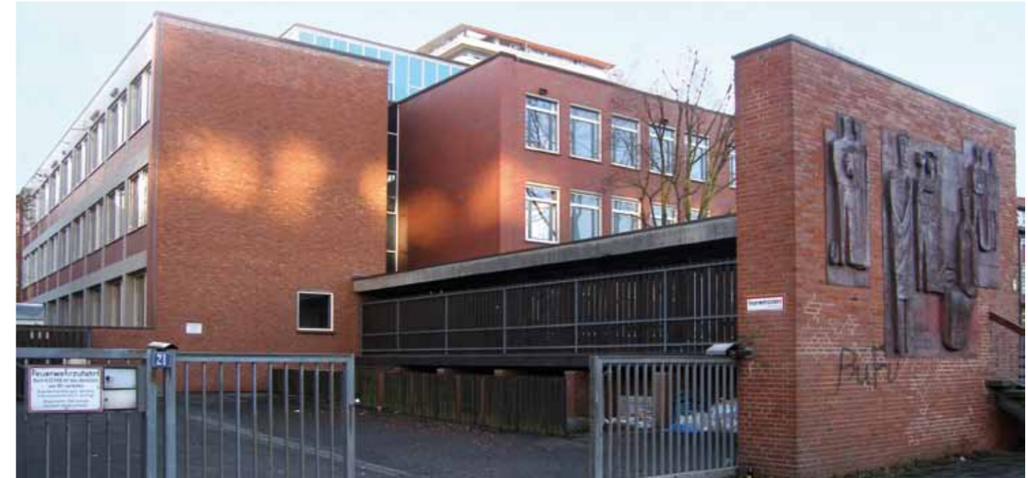
Das denkmalgeschützte Gebäude erforderte einen sensiblen Umgang mit den Fassaden
