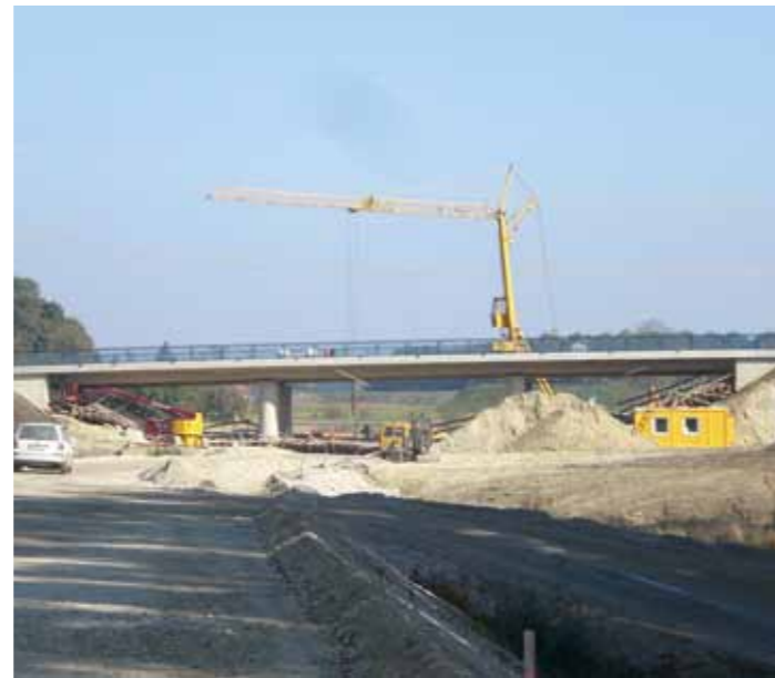
Brücke über die FTO, BA 5
