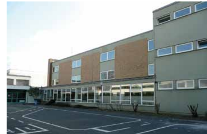
Schule vor der Sanierung
