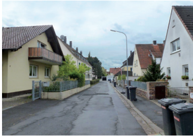
Die Straßen und Gehwege in älteren Einfamilienhausgebieten sind oftmals verbesserungsbedürftig.
