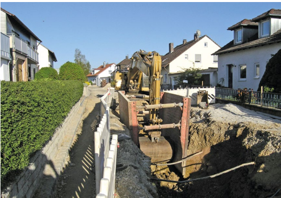
Sanierung der Infrastruktur im Bestand
