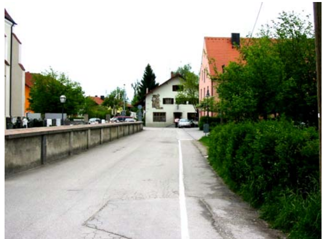
Schulwegsicherung durch Gehwegausbau (Pfarrer-Andrä-Straße)
