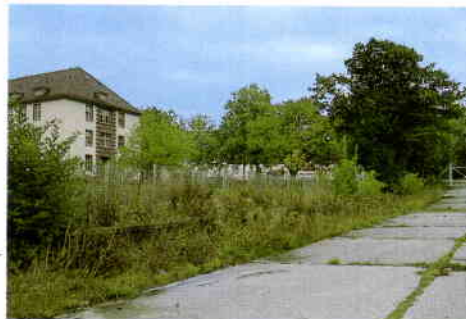
Versiegelung mit groß- flächigen Betonplatten
