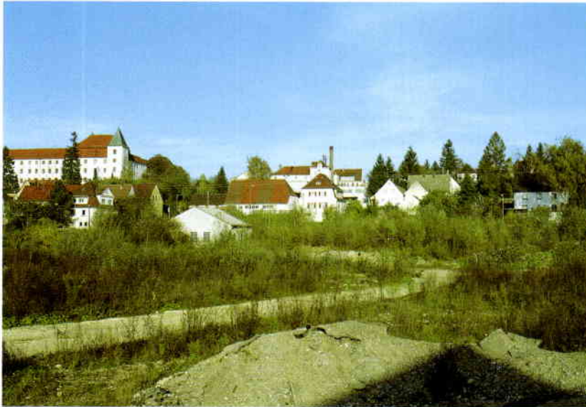
Siedlungsmodell Günzburg »Günzpark«: Blick von Westen auf das Areal der ehemaligen Süddeutsche-Baumwolle- Industrie. Im Umgang mit einem aus der Vornutzung belasteten Standort müssen ökonomisch und ökologisch sinnvolle Lösun- gen gefunden werden.
