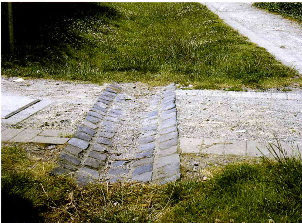
Offene Regenwasserableitung in einer Rasenmulde
