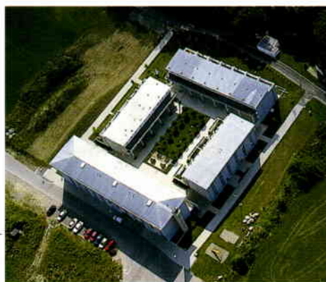
Erster Bauabschnitt »Wohnhof 3« (Arch. Fink + Jocher)
