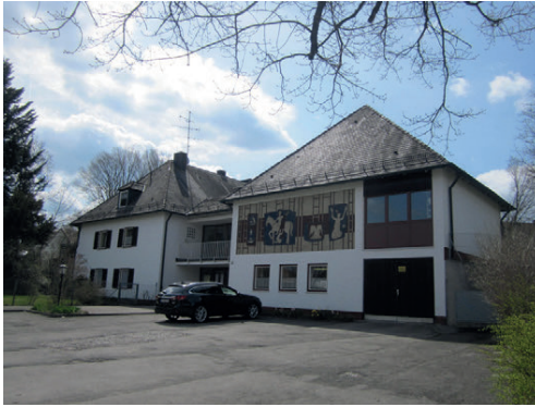
Pfarrhaus als Multifunktionsgebäude
