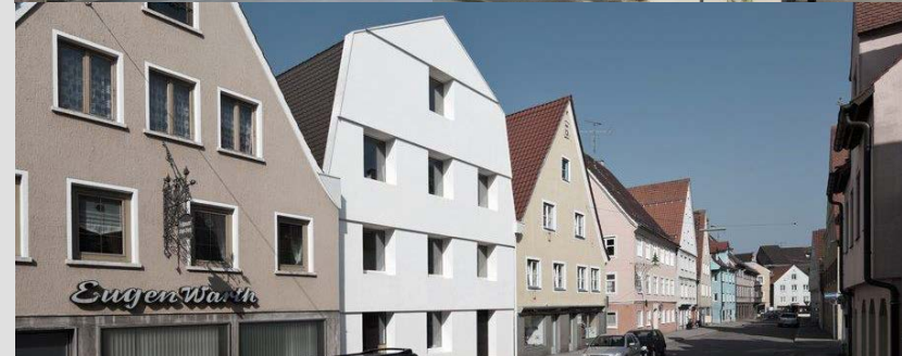
Sanierung / Umnutzung / Neubau
