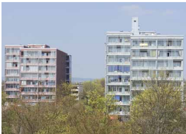
Geschosshohe Wintergärten als Wärme- und Schallpuffer
