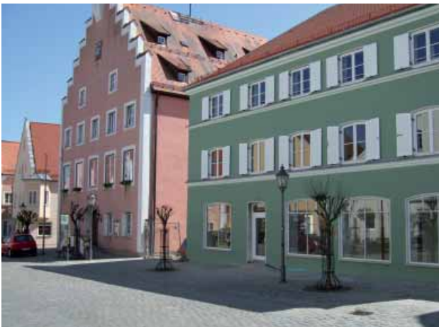
Sanierung und Umnutzung des Anwesens Marktplatz 25 im Zentrum von Langquaid als Haus der Begegnung
