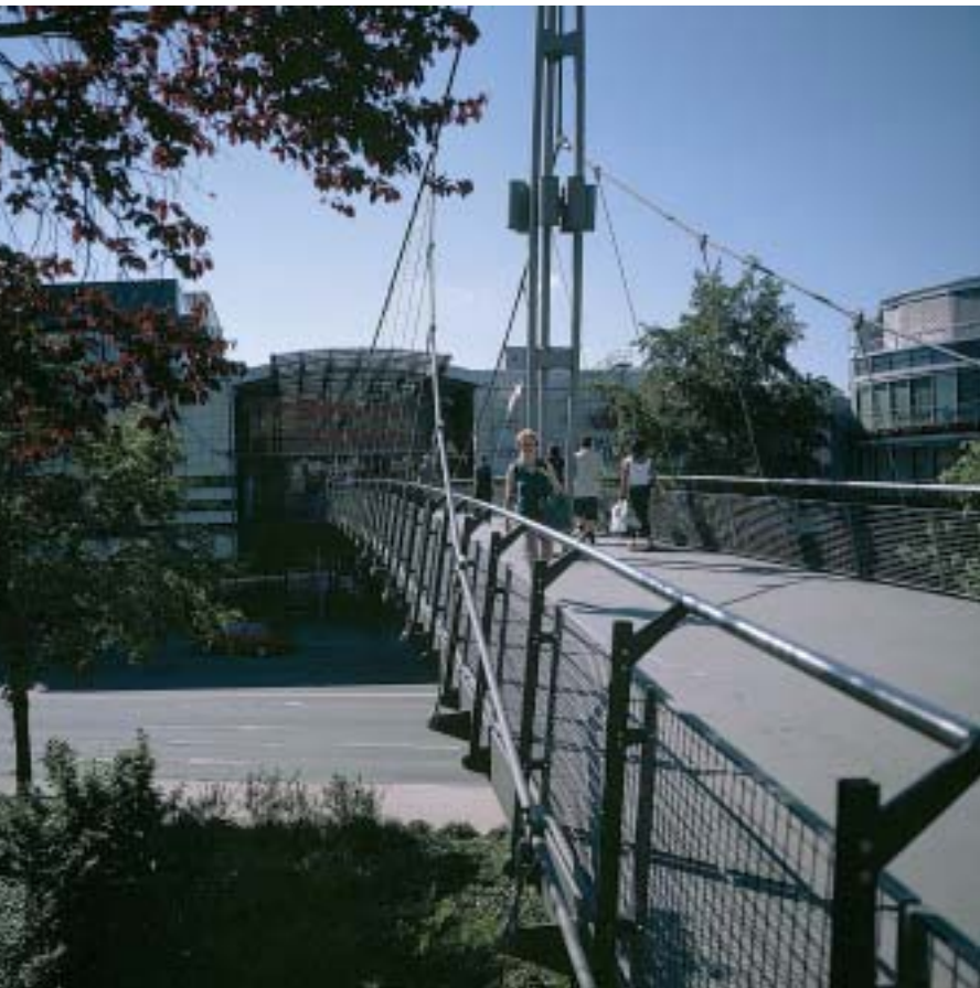
Blick auf das Rotmain-Center. Der Fußgängersteg verbindet den Haupteingang mit der Fußgängerzone in der Altstadt
