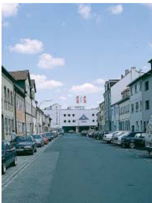
Das Atrium schließt den Straßenraum zum Bahngelände hin ab
