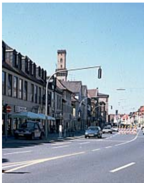
Blick von der Königstraße auf das Einkaufszentrum. Der Neubau orientiert sich mit Traufe, geneigtem Dach und Fensteröffnungen am Maßstab der Umgebung
