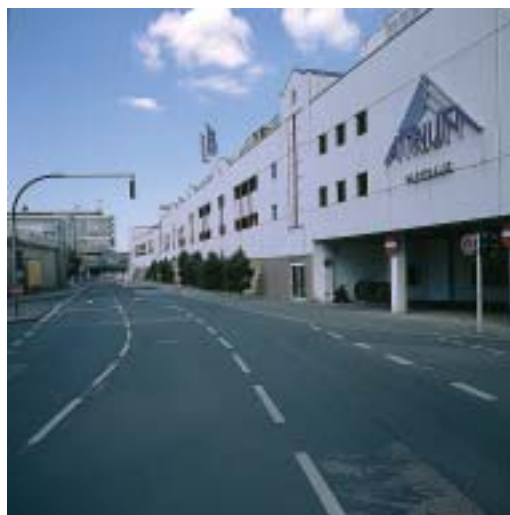
Das Parkhaus befindet sich am bahnhofsabgewandten Ende des Objekts
