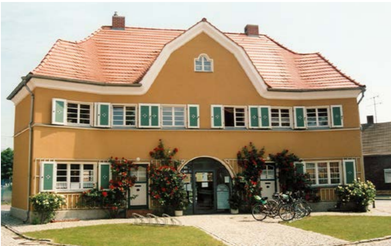
Abb. 6: Torhaus nach der Sanierung (Foto: Gerhard Leske, Piesteritzer Servicegesellschaft)
