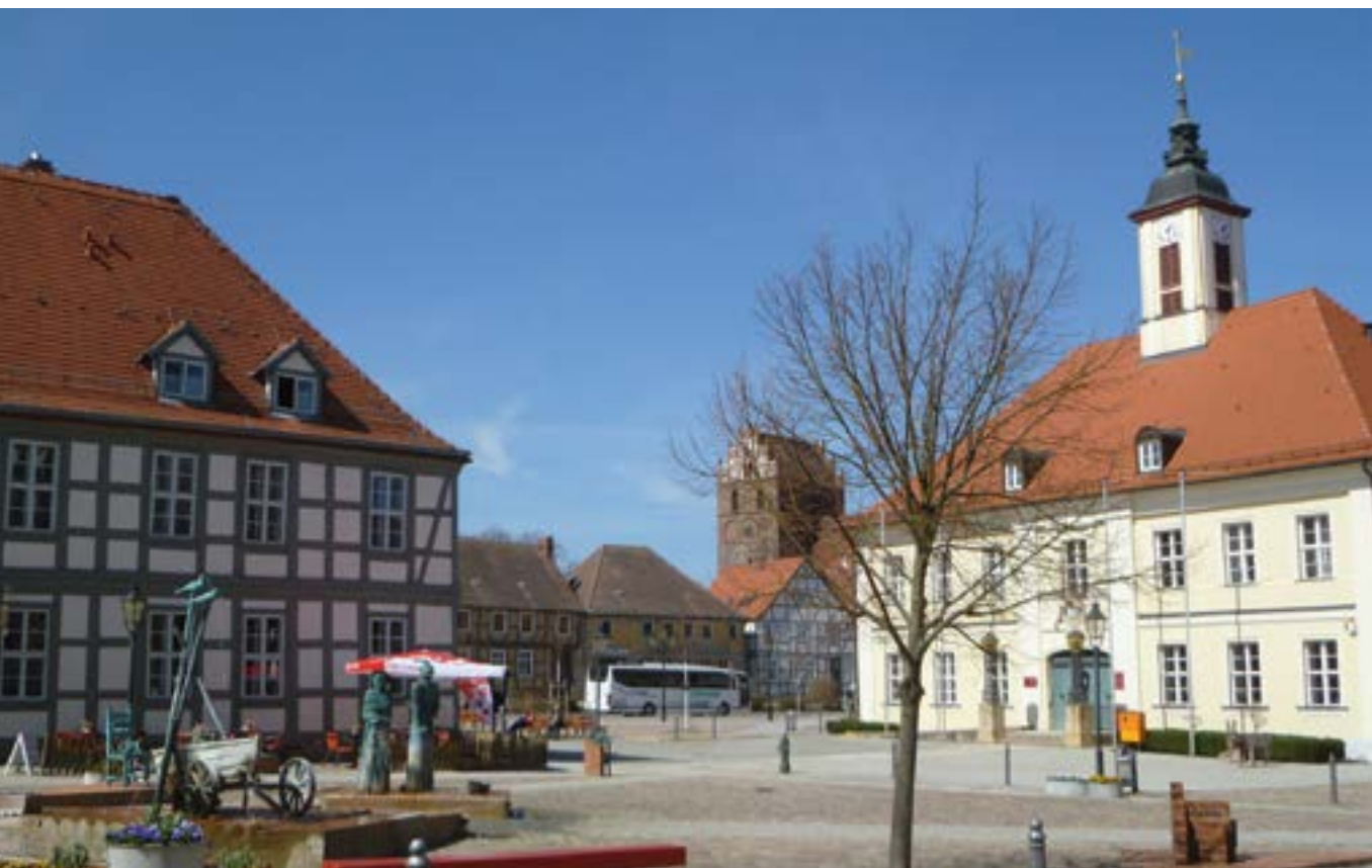
Abb. 1: Marktplatz mit Rathaus und Brunnen, im Hintergrund Marienkirche und zwei sanierungsbedürftige barocke Häuser, die zum Museum entwickelt werden sollen (Foto: Stadtverwaltung Angermünde Uta Walch)
