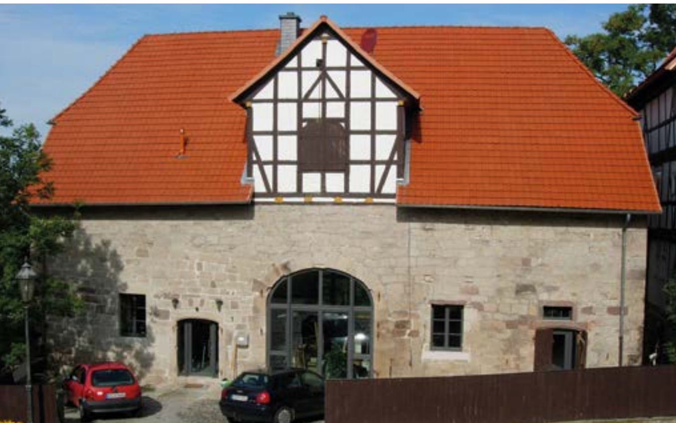
Abb. 3: Umnutzung einer Scheune (Foto: Landesamt für Denkmalpflege Hessen)
