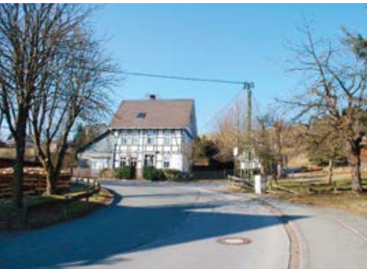
Abb. 4: vorbildlich erneuertes Gebäude im Ortsteil Westernbödefeld (Foto: pesch partner architekten stadtplaner)
