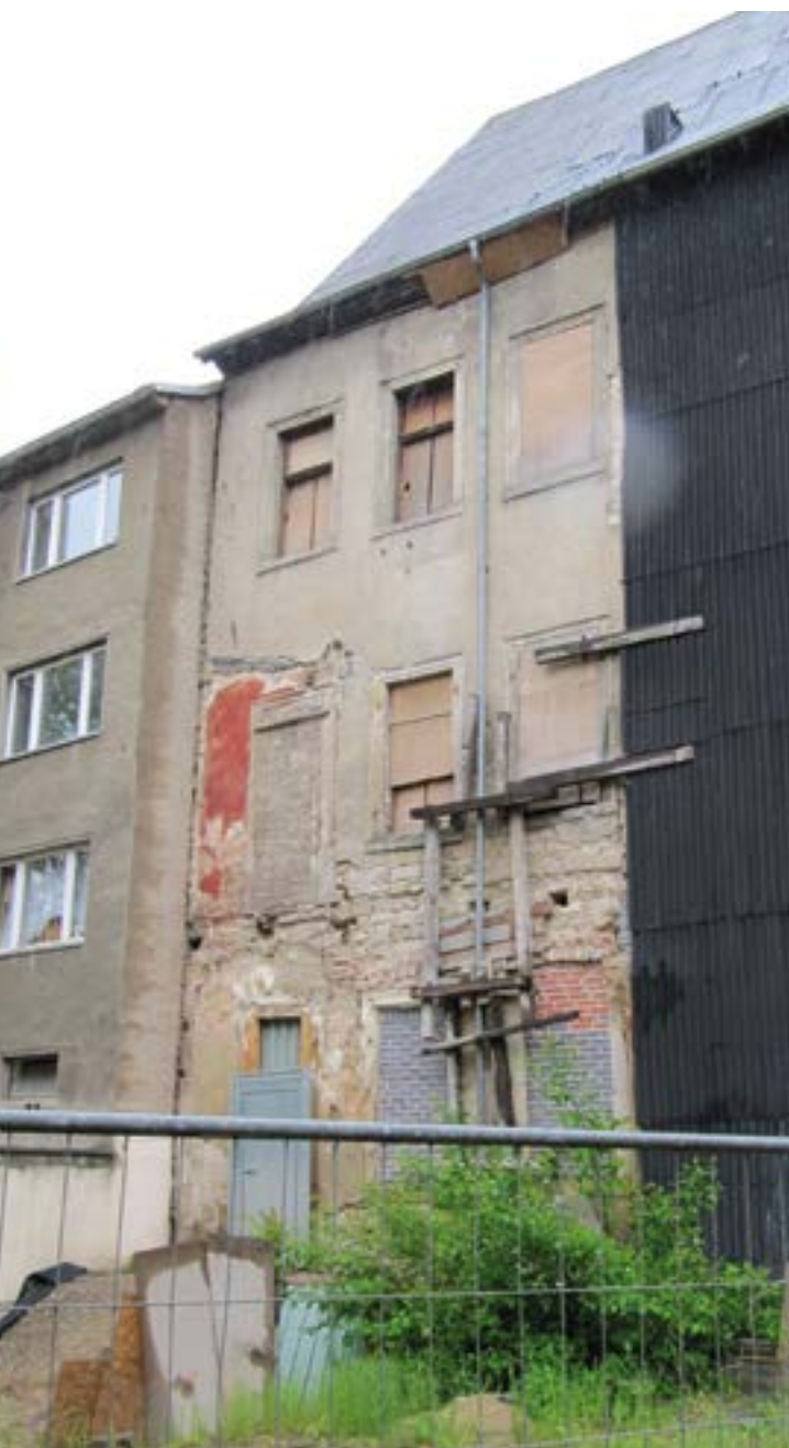
Abb. 2: Zustand Hofseite im Frühjahr 2013 (Foto: Eckhard Hasler)
