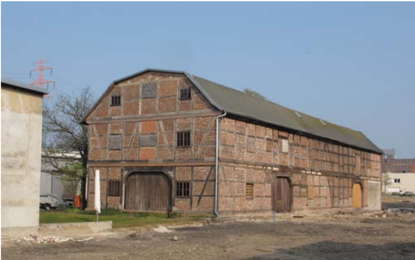
Abb. 6: Instandgesetzte Fachwerkkonstruktion des Kaufhausspeichers. (Foto: Schwarzkopf)
