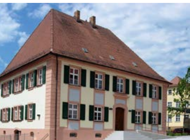
Abb. 5: Steingruberhaus – Bürger- und Kulturhaus, früheres Schulhaus (Foto: Stadt Merkendorf)
