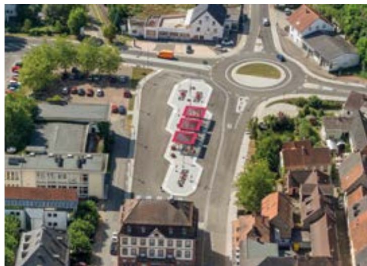
Abb. 2: Der neue Busbahnhof mit Kreisverkehr (Foto: Stadt Blieskastel)
