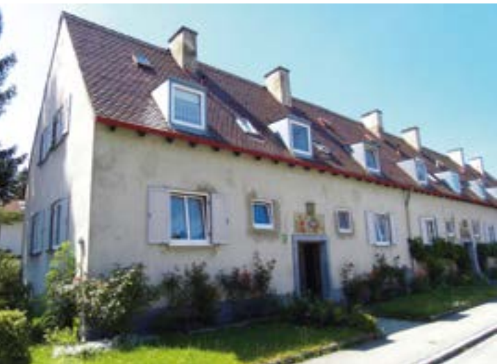
Abb 10: Fliegiersiedlung München vor der Sanierung (Foto: Prof. Dr. Detlef Kurth)
