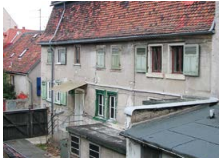
Abb. 1: Darmstadt - der Sandberghof vor der Sanierung (Foto: Landesamt für Denkmalpflege Hessen)
