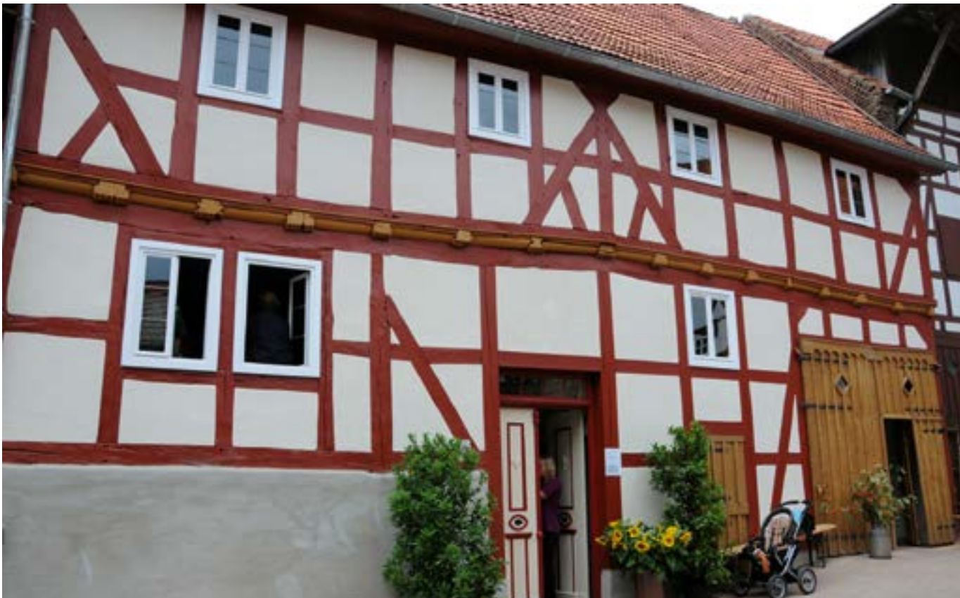
Abb. 6: Gebäude in Sachsenberg (Lichtenfels) nach Abschluss der Sanierung (Foto: Landesamt für Denkmalpflege Hessen)
