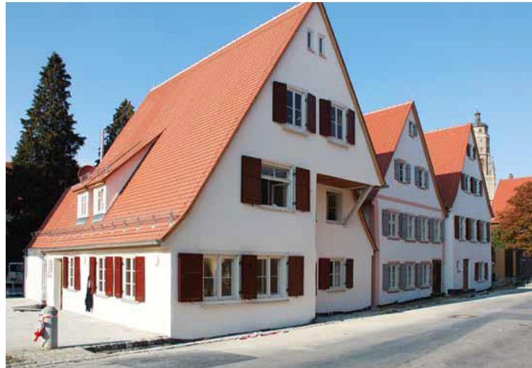
© mbi Mitnacht Beratende Ingenieure, Würzburg Nördlingen Bräugasse 8, 10 und 12, Straßenansicht
