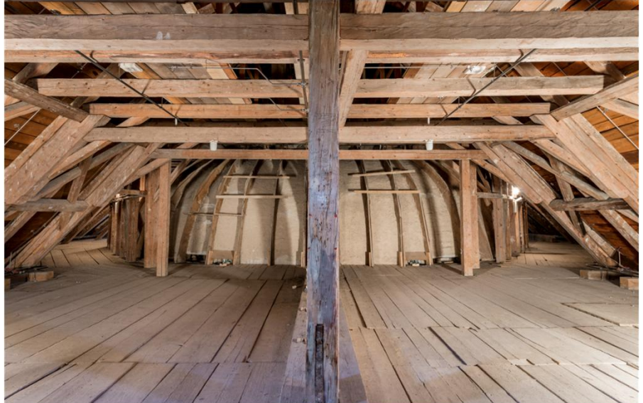
Dachraum mit Spantengewölbe – Foto Achim Bunz
