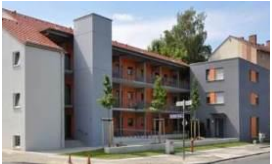
Rampe, Laubengänge und Ergänzungsbau jeweils an der Nordfassade (Foto: Karin Sandeck, OBB) © Experimenteller Wohnungsbau
