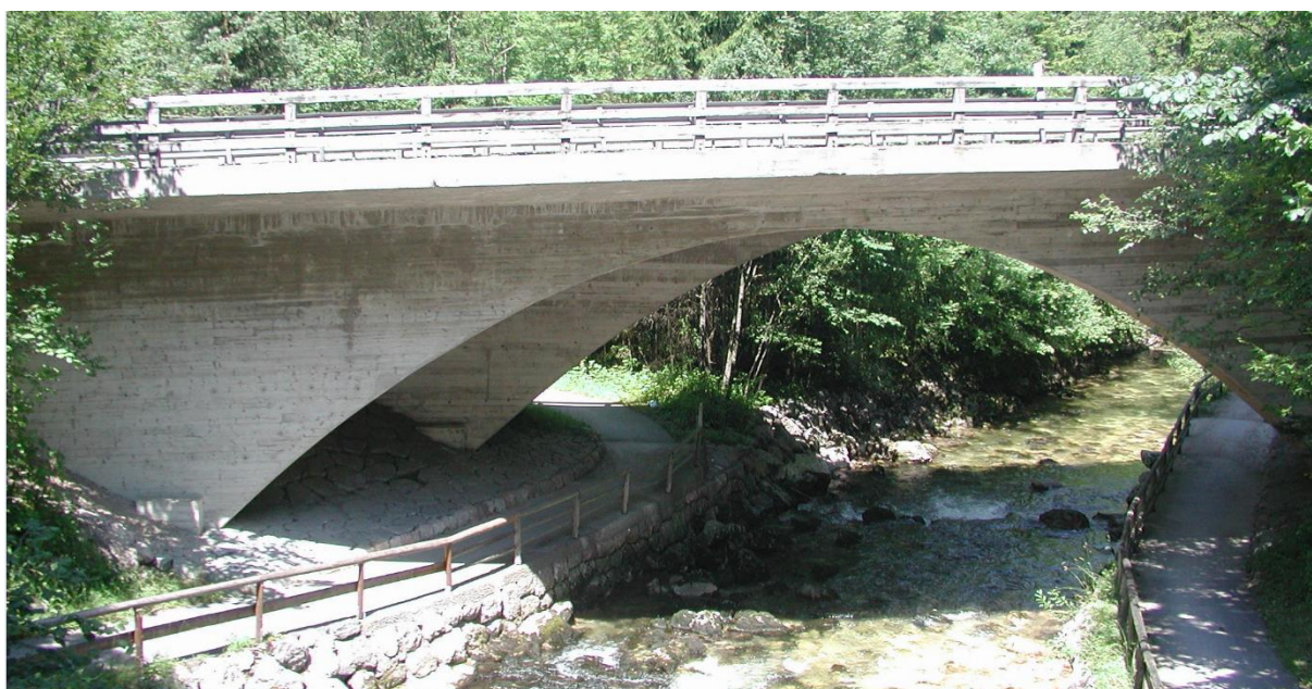
Abbildung 8: Brücke mit Bogenscheiben aus Stahlbeton
