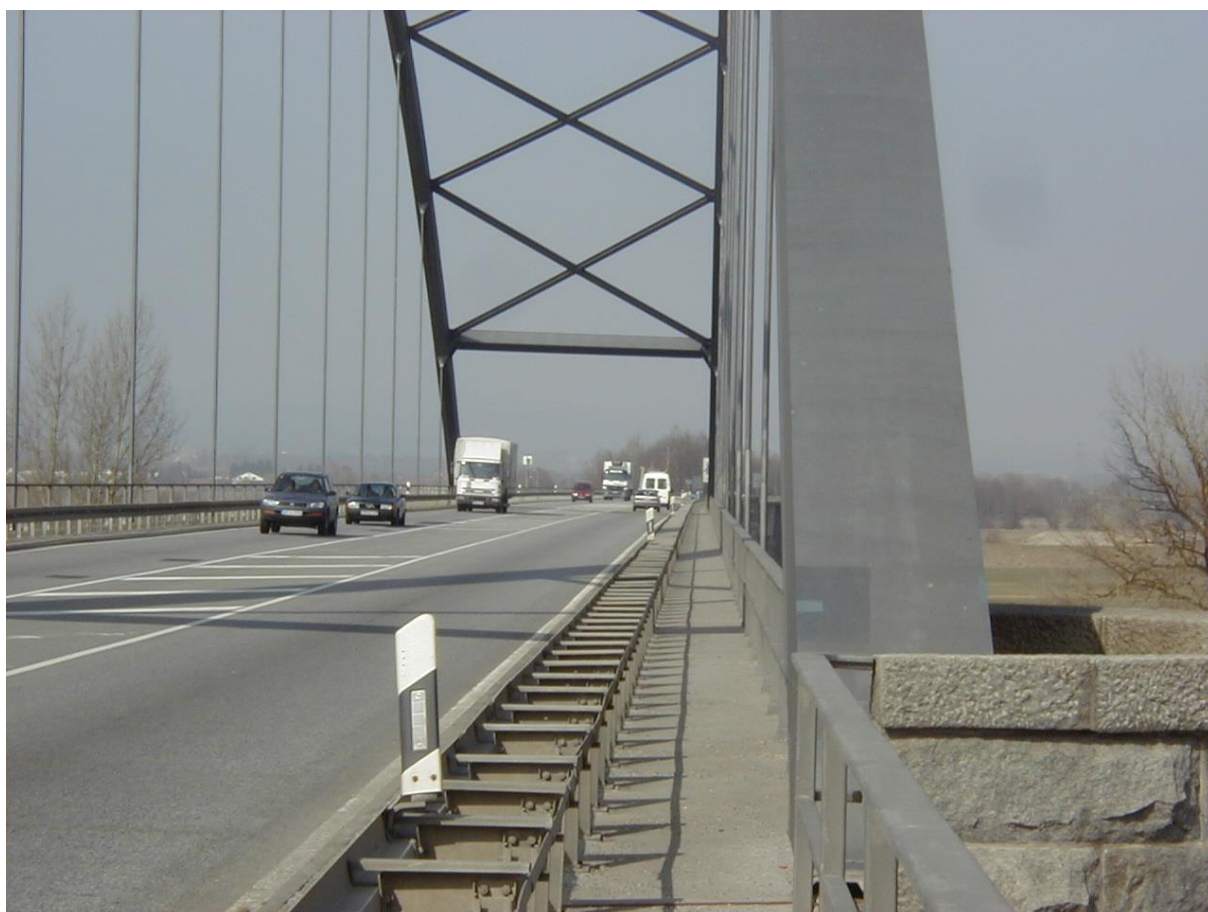
Abbildung 5 Bogen mit abgehängter Fahrbahn.
