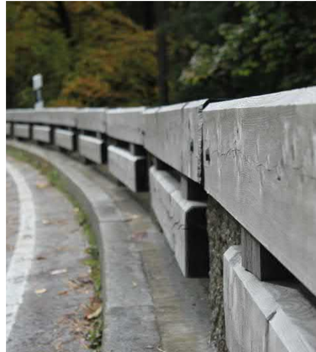
» Abb. 40 Provisorische Unterfahrschutz-Sonderkonstruktion an der Bundesstraße B 20 (Abschnitt 180; Station 7,360)
