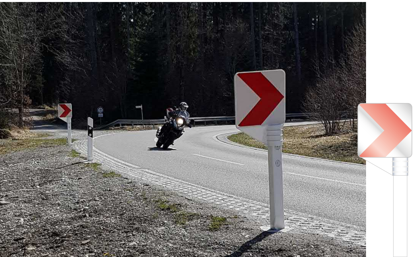
» Abb. 43 Im Rahmen der bayernweiten Aktion „Sichere Motorradstrecke“ aufgestellte flexible Kurvenleittafeln
