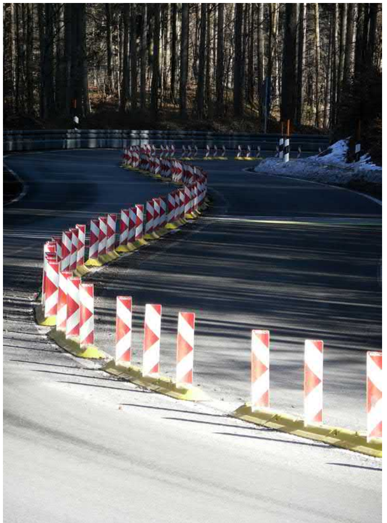
» Abb. 37 Mittelleitschwellen mit Baken auf der Bundesstraße B 11 am Kesselberg (Abschnitt 200; Station 2,800)
