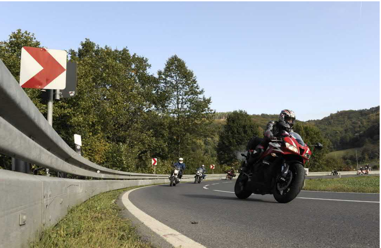
» Abb. 33 Erfolgreiche Maßnahme zur Verbesserung der Verkehrssi- cherheit: Schutzplanke mit nachgerüstetem Unterfahrschutz, hier in der Fränkischen Schweiz
